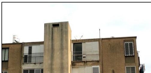
דוגמה לא רצויה: חומר איטום שגלש מגג המבנה, בגלל מעקה גג נמוך מדי
